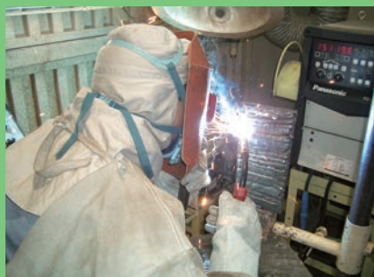
Soldagem CO 2 ・MAG
